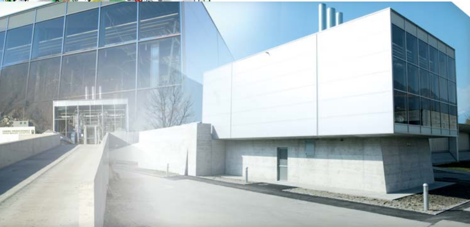
La centrale termica, volutamente messa in evidenza attraverso un'architettura di qualità
