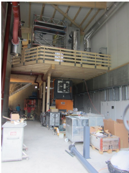
Einbau des ersten Heizkessels mit dem Elektrofilter auf dem Podest im Jahr 2016
