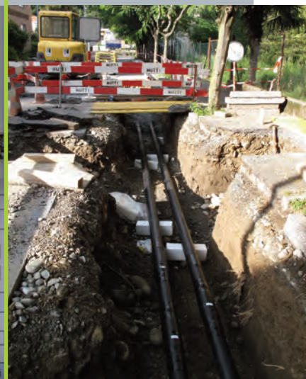
Tubazioni per il teleriscaldamenti
