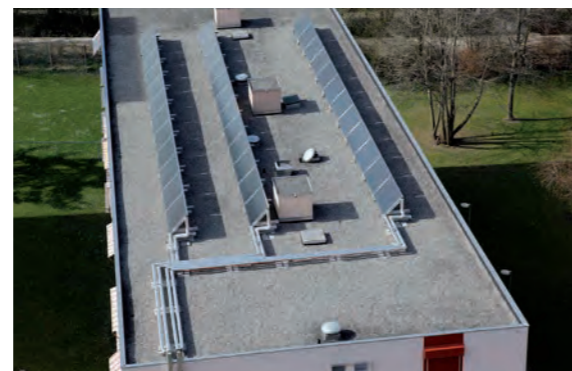
L'installation d'un système de préchauffage est pratique et indépendante des autres mesures d'efficacité énergétique. Par ailleurs, le volume d'investissement est raisonnable et la complexité modérée. Photo : Ernst Schweizer AG, Metallbau
