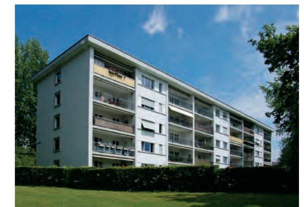
Les appartements du complexe Riedhofpark de Zurich Höngg sont désormais chauffés au gaz, dont 20% provenant de biogaz neutre en CO 2 .
