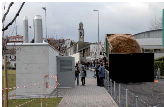
Il riempimento di cippato del teleriscaldamento di Coldrerio (TI)
