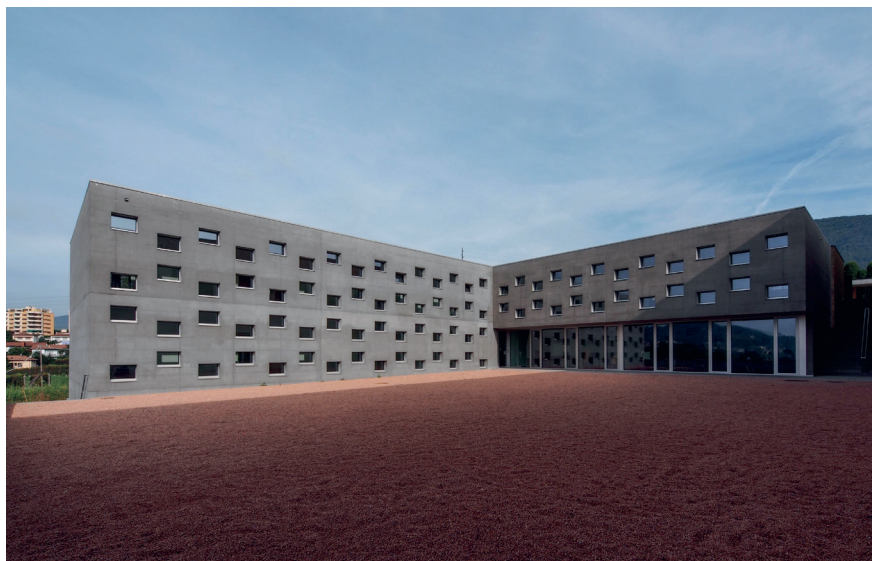
«Il Centro professionale del verde di Mezzana, dal 2019 riscaldato a cippato» (Foto: Bardelli Architetti associati)
