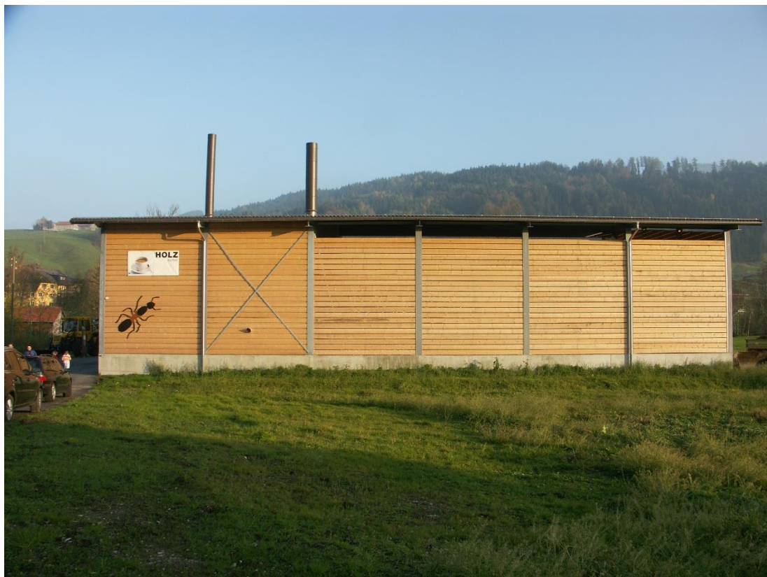
Quelle: Wärmeverbund Urnäsch © Holzenergie Schweiz
