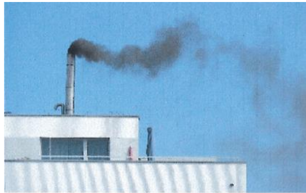
Bild 2 Auf diesem Foto ist eine starke Rauchentwicklung sichtbar. Daraus kann aber nicht erkannt werden, ob das Ereignis 30 Sekunden oder 5 Minuten gedauert hat. Ein Video zeigt dies besser.
